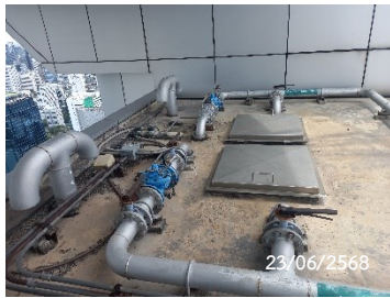
ลักษณะถังเก็บน้ำชั้นดาดฟ้า และ Booster Pump ของแต่ละอาคาร
