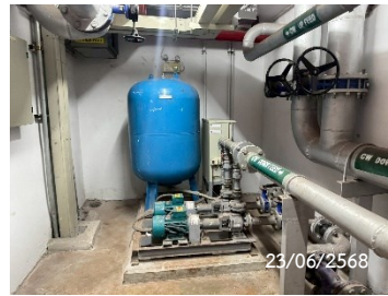
ลักษณะถังเก็บน้ำชั้นดาดฟ้า และ Booster Pump ของแต่ละอาคาร
